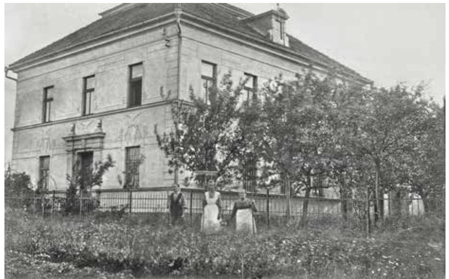
Im Jahr 1909 wurde ein ca. 80 m Zaun mit zwei Gattern rund um das Pfarrhaus errichtet, 1940 wurde dieser entfernt.
