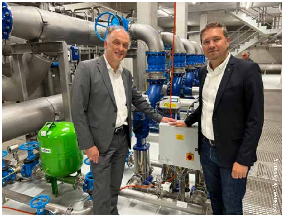
Aktuell endet die Vorbereitung zur zweiten Wasserleitung für Thurnharting beim Gehweg nach dem LILO-Bahnübergang.
